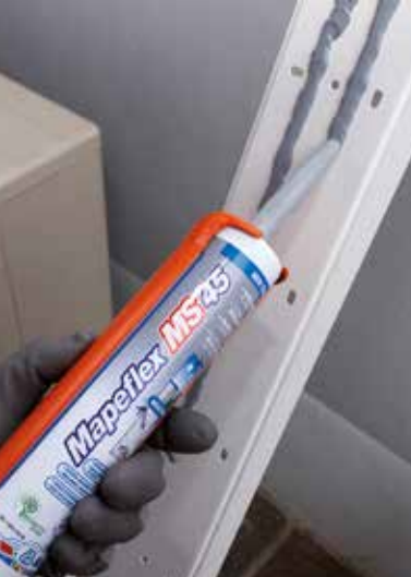
Incollaggio di profili in plastica in esterno
